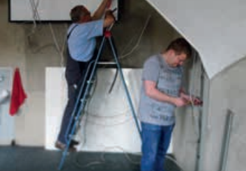
Abbruch, erst das Elektrische
